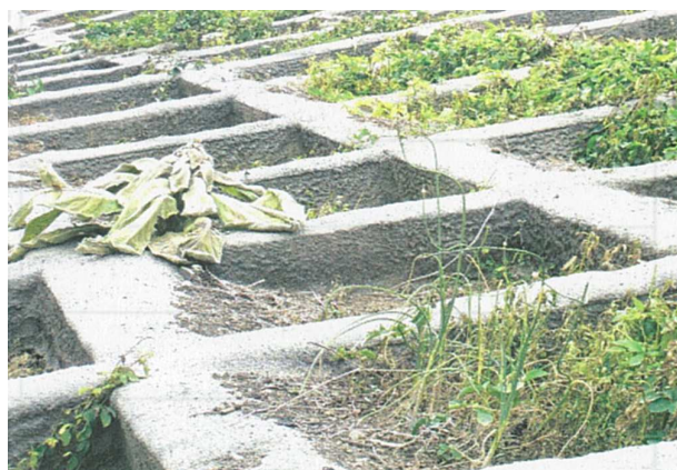
作業約一週間経過後
