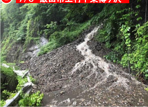
【被害状況等】林道通行止め
