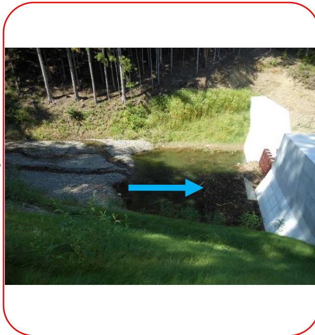
土石流発生後 (R3.8.30撮影)
