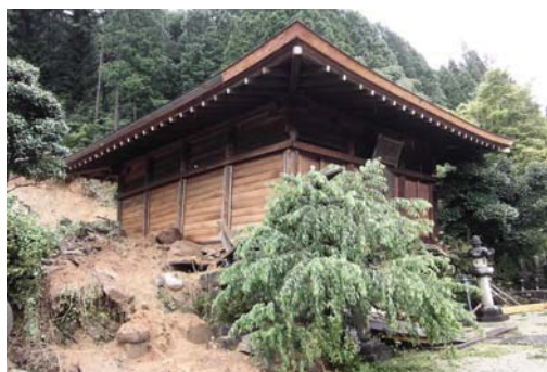
② 木曾郡大桑村 下落(がけ崩れ)
