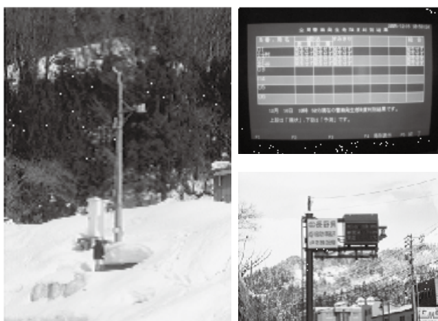
観測装置(左)・モニター(右上)・砂防情報盤(右下)
