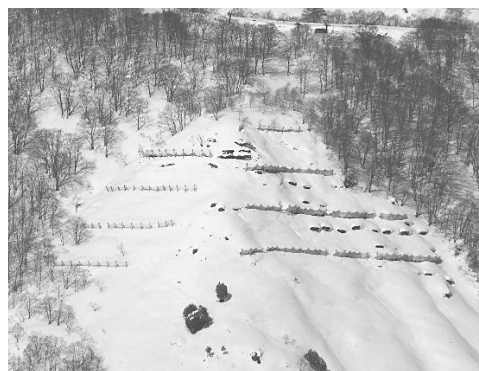
飯田地区 雪崩予防柵完成写真
