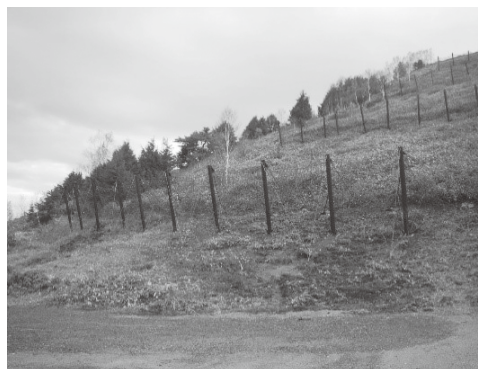
硯川地区 雪崩予防柵完成写真
