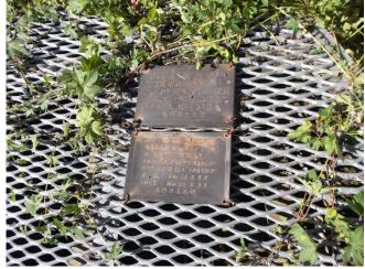
集水ボーリングから地下水を集水井に集め、排水ボーリングから排出することで、地すべりを引き起こす原因の一つである地下水を地中から排除するための対策工です。集水井の大きさは、一般的には直径  $3.5\sim4.0\,\mathrm{m}$ 、深さ  $20\sim30\,\mathrm{m}$  ほどで、井戸の中には点検用のはしごがあります。
