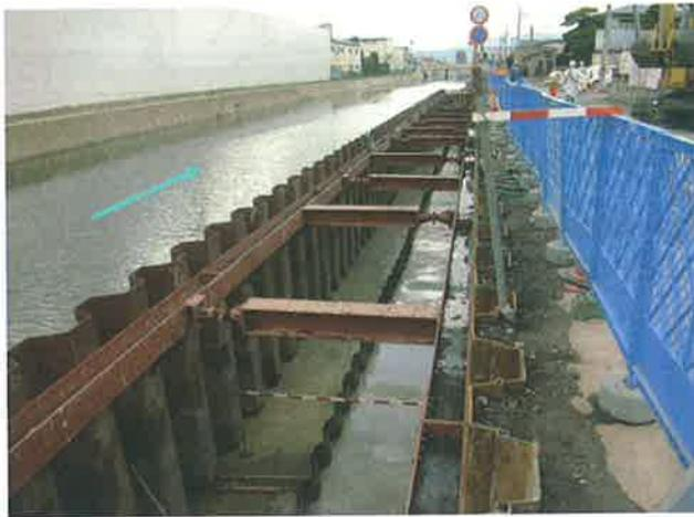
擁壁護岸工ベースコンクリート打設完了
