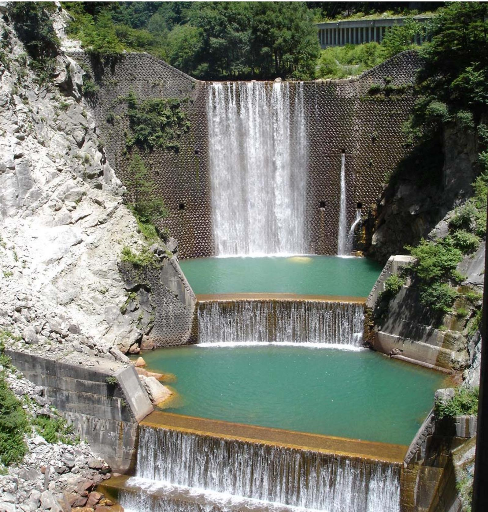
昭和19年に完成した日本で初めてのアーチ式砂防堰堤です。
