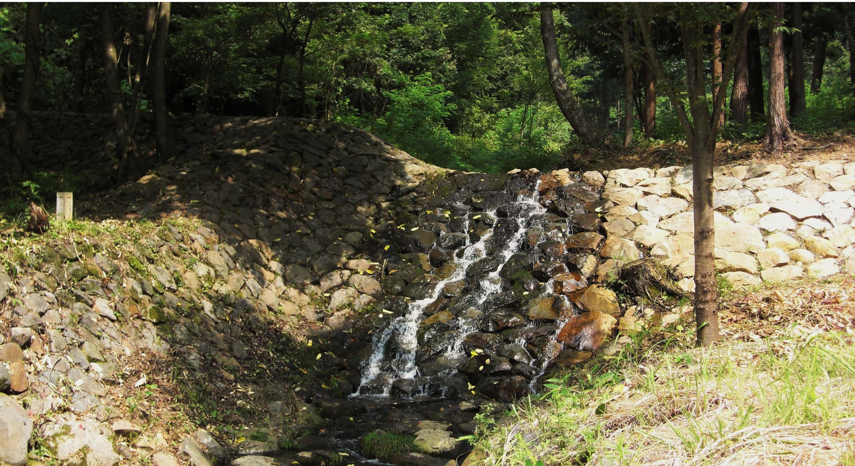
佐野川流域では明治14年から信濃川下流対策として内務省直轄による砂防工事が行われ、100基以上の堰堤が造られました。荏沢川には現在4基の石積堰堤が現存しており、地元有志により草刈りや清掃が行われています。
