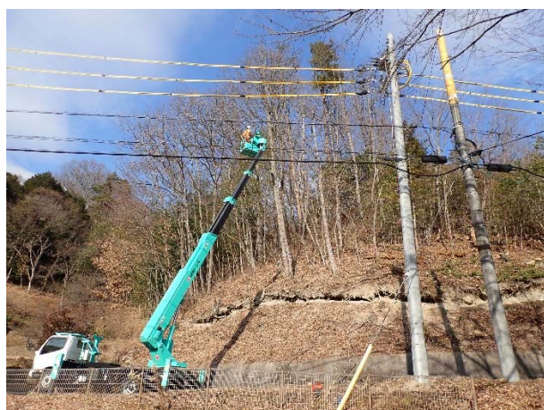
写真 2-1 EWP による伐採作業（左：阿南町）とラフタークレーンによる伐倒作業（右：松本市） EWP には作業員 2 名、ラフタークレーンの搭乗設備には作業員 1 名（ともに安全帯を装着して搭乗）
