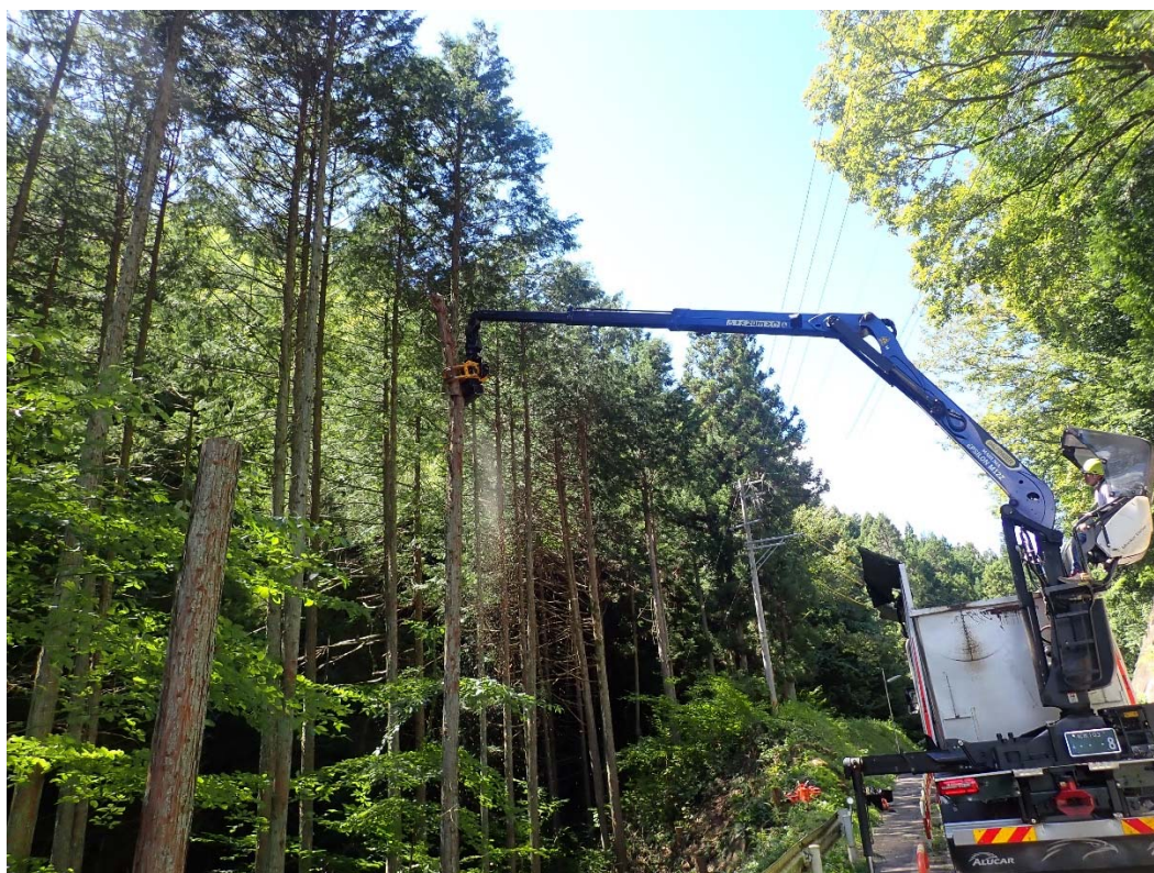
写真 1-3 フェリンググラップル伐倒作業 （有）矢守産業 下條村事業現場 GMT035
