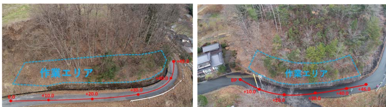
図.1 阿智村伍和地区(左)と阿南町西條地区(右) 阿智村伍和地区は1日換算道路延長53.0m、1日換算重量7.33トン 阿南町西條地区は1日換算道路延長55.5m、1日換算重量6.81トン
