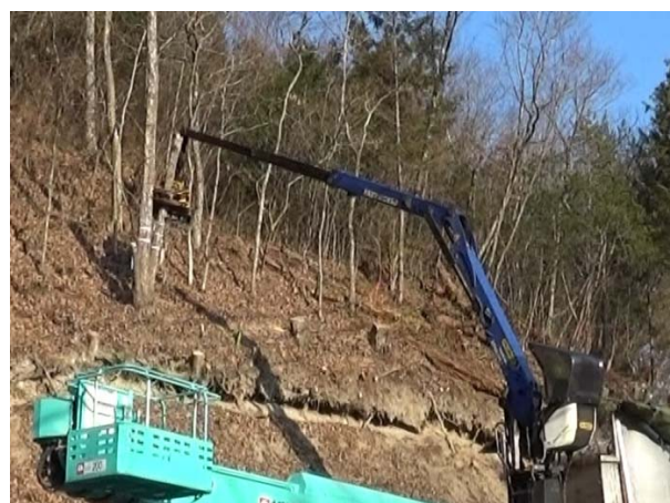
写真 2-11 樹高が高い木のチェーンソー 先行伐倒
