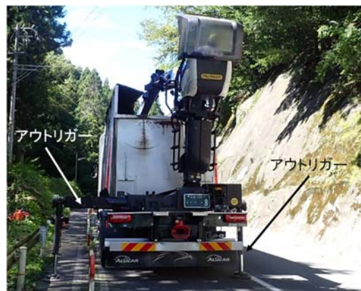
図 2-6 アウトリガー設置状況
