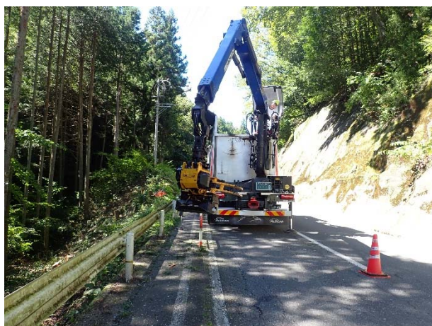
写真 2-14 二車線道路での車線規制作業
