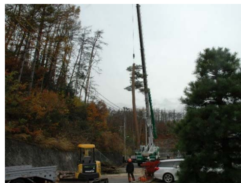
写真 1-1 ラフテレーンクレーンによる特殊伐採
