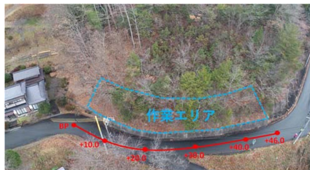
図2-3 阿南町西條の現場（ドローン空撮画像）
