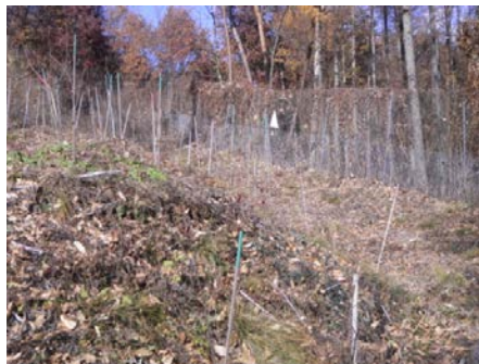
侵入防止柵の設置
