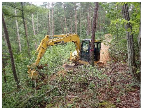
作業道の作設
