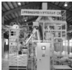
ペレット製造工場
