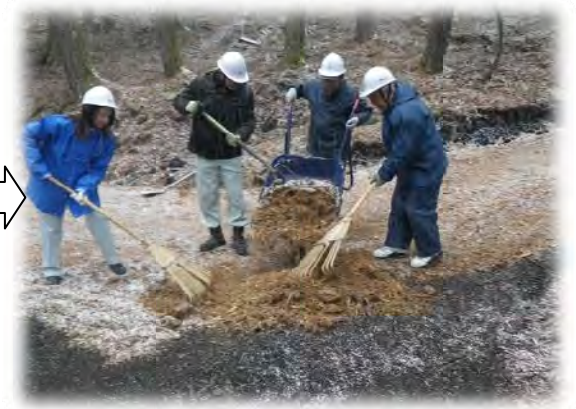
破碎後、林内の歩道へチップの敷き均し
