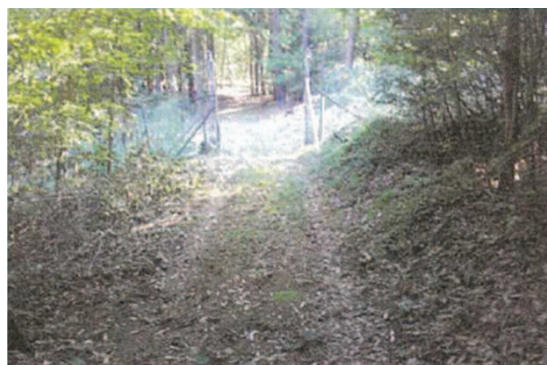
▲整備後 道路整備（松川町）
