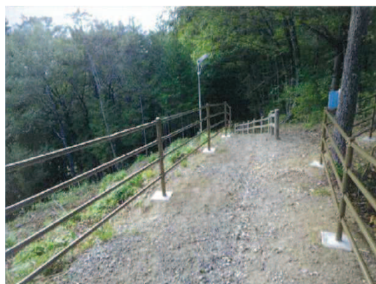
▲整備後 転落防止柵整備（喬木村）
