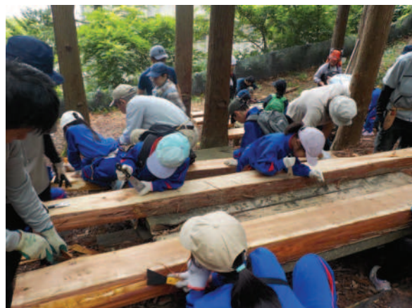
▲ツリーテラス製作作業(長野市)
