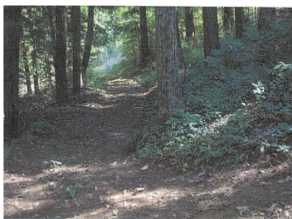
▲整備前 道路整備 (松川町)
