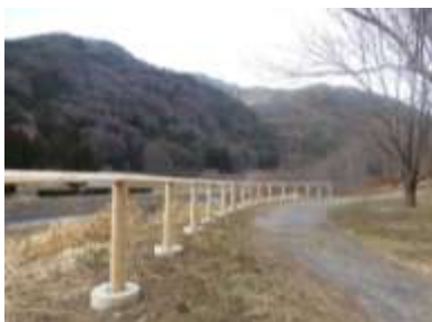
木曾郡辰野町: 木製転落防止柵の設置 ほたる童謡公園内に、県産材を活用した転落防止柵を設置し、県産材をPR
