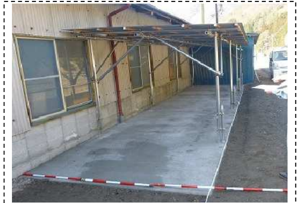
薪ステーションの舗装
