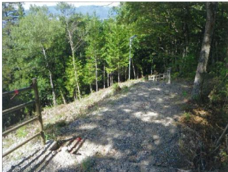
▲整備前 転落防止柵整備(喬木村)
