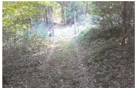
▲整備後 道路整備(松川町)
