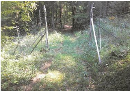
▲整備前 道路整備(松川町)
