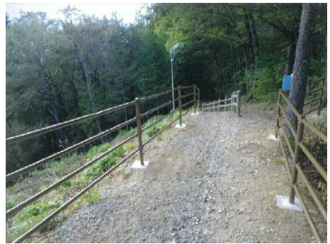
▲整備後 転落防止柵整備(喬木村)
