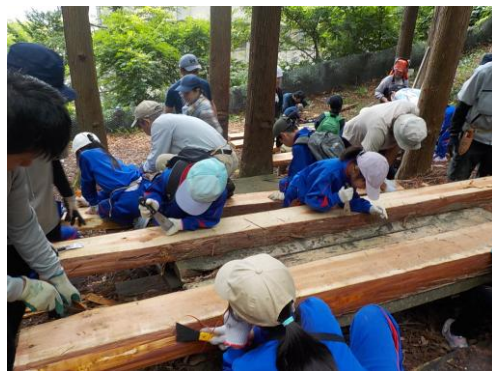
▲ツリーテラス製作作業(長野市)
