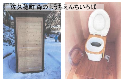
フィールドが園舎から離れているため、コンポストイレを設置
