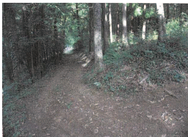
▲整備後 道路整備 (松川町)
