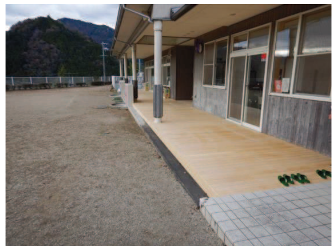
▲天龍保育所（デッキテラス）（天龍村） CO2固定量2.9 t
