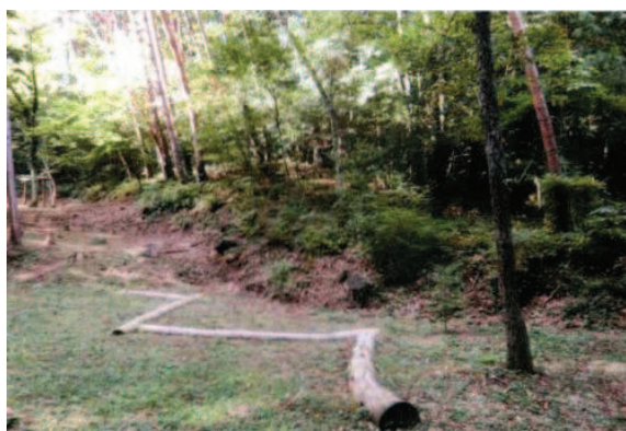
▲整備前 危険木等伐倒 (飯田市)
