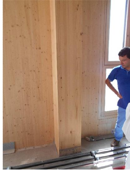
【集成材の柱と CLT の壁材】
