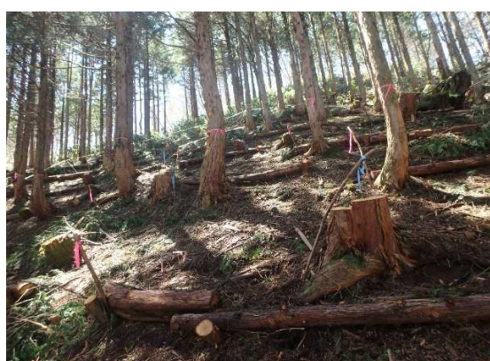
森林整備と筋工の組み合わせによる整備状況
