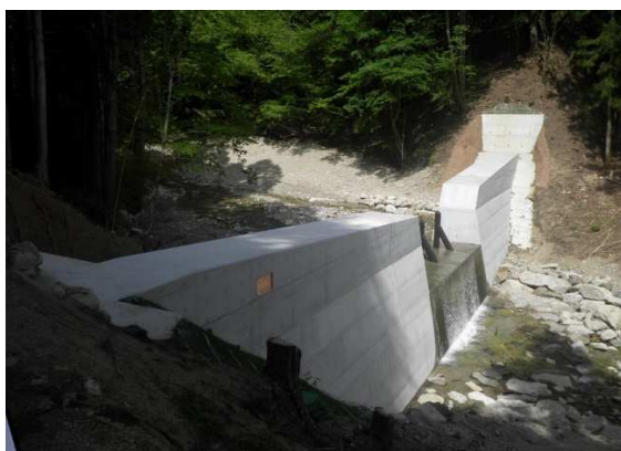
流木捕捉式治山ダムの設置状況
