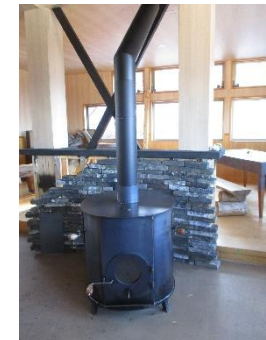
薪ストーブ設置（中川村）
