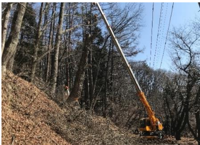
ライフライン（ここでは電線）沿いの危険木伐採
