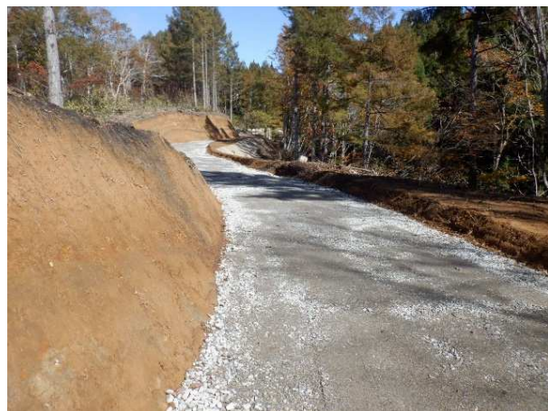
R4 県営林道 古海線開設
