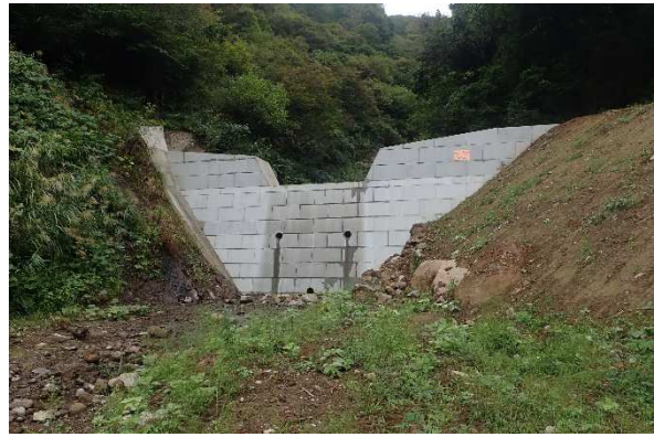
治山ダムの設置状況
