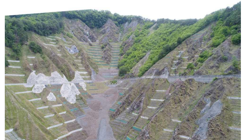
小渋川地区山腹工事（大鹿村）
