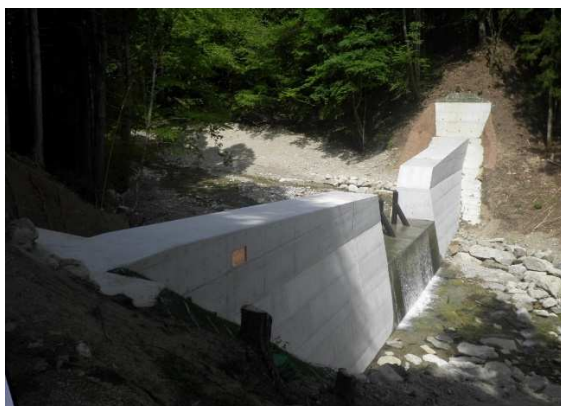
流木捕捉式治山ダムの設置状況
