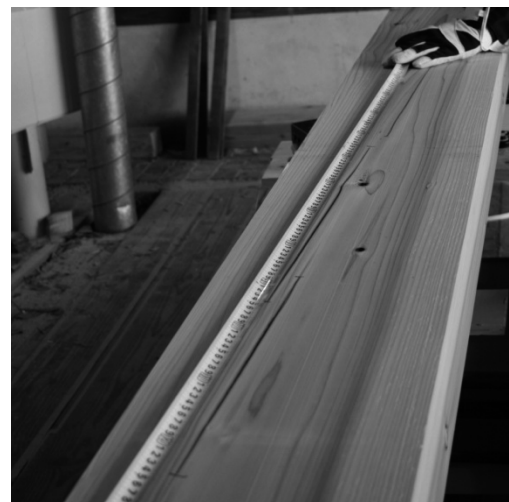
写真 6 平角材モルダー加工後の材面割れ
