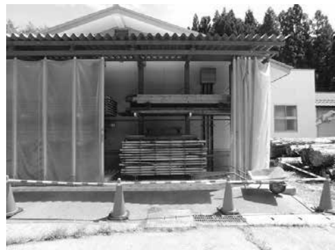
写真-16 屋外乾燥状況
