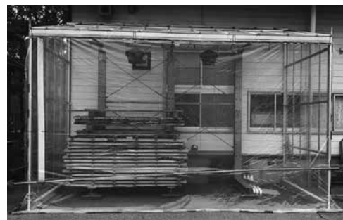
写真-17 ガラスハウス乾燥状況
