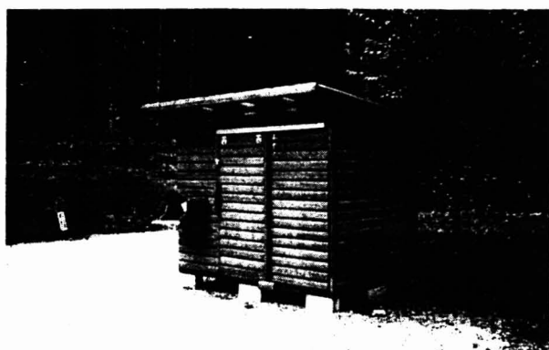
写真-7 軸組タイプのストックハウス(1.5坪)の完成 防腐塗装は木材保護着色剤による
