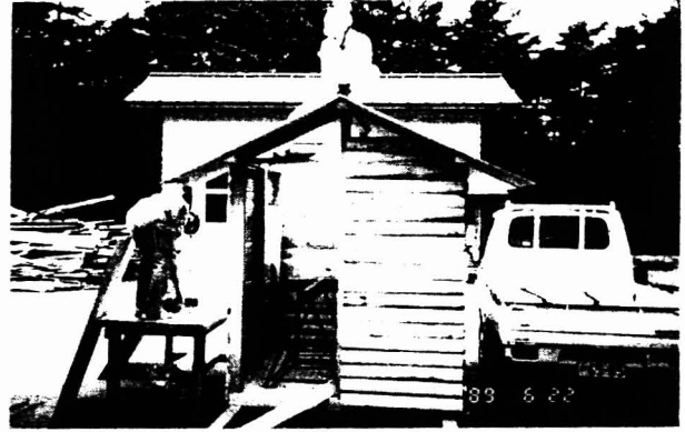
写真-12 頭つなぎ及びコンパネ(野地板)を打ち付ける
