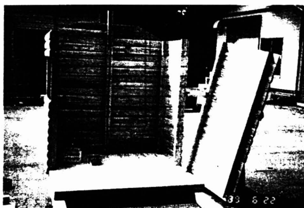
写真-10 壁パネルを組立てていく
