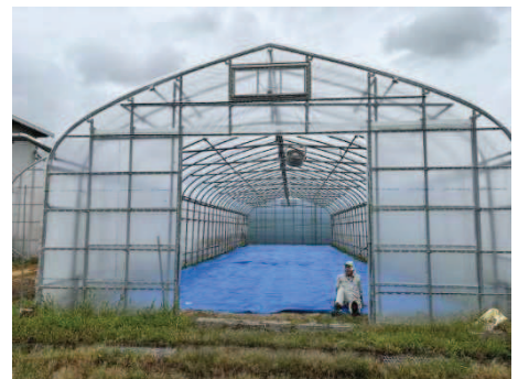
写真-3 ビニールハウス外観
