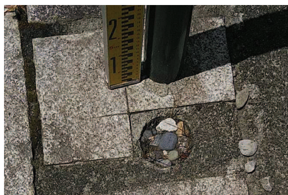
写真-1, 2 木製柱→鋼製柱移行箇所（駒ヶ根市光前寺）・同木製柱撤去跡（φ80mm）
