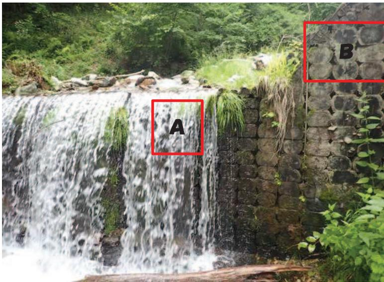
写真-1 部材交換（試験体採取）位置
