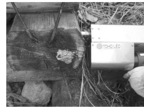
写真3 レジストグラフによる劣化調査の様子
