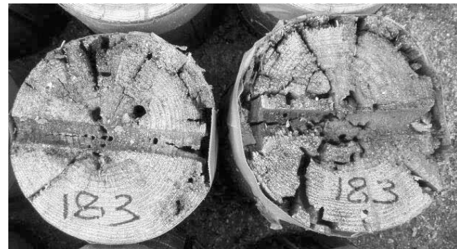
写真12 3号型横梁部材断面 (心材部まで劣化)
