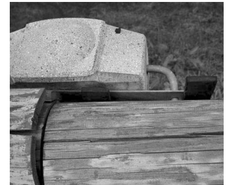
写真13 ボルトを緩め、クッション材を支柱と横梁部材の間に挟む
