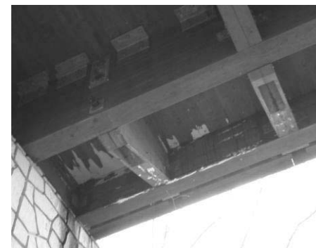
写真6 菌糸が発生した木橋
