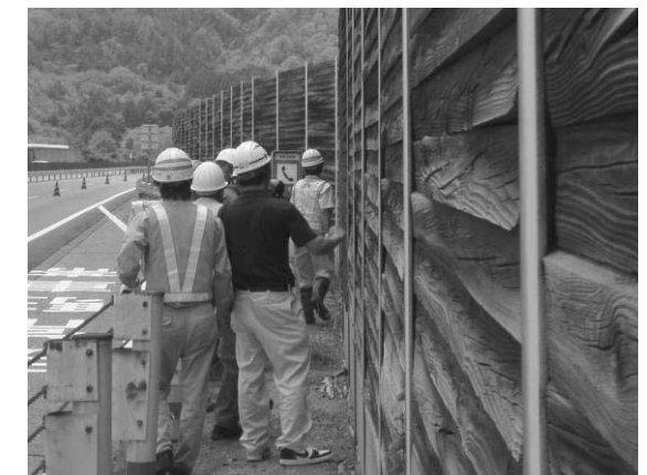
写真4 施工後26年経過した木製遮音壁
