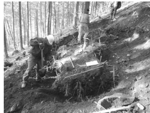
写真-1 掘削作業
