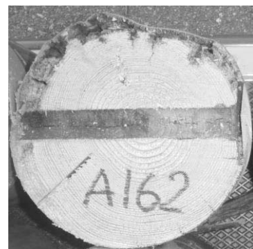
写真11 3号型横梁部材断面 (辺材部のみ劣化)
