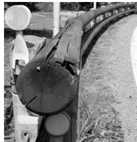
写真9 辺材部が剥離した 信州型木製 Gr 3号型
