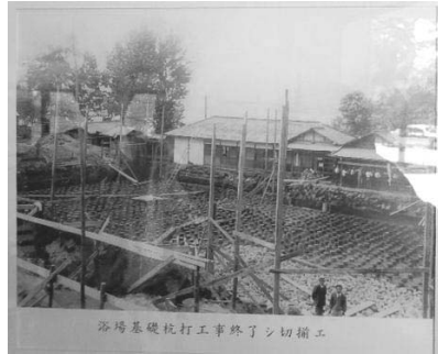
(写真-1) 諏訪市片倉館丸太基礎工
