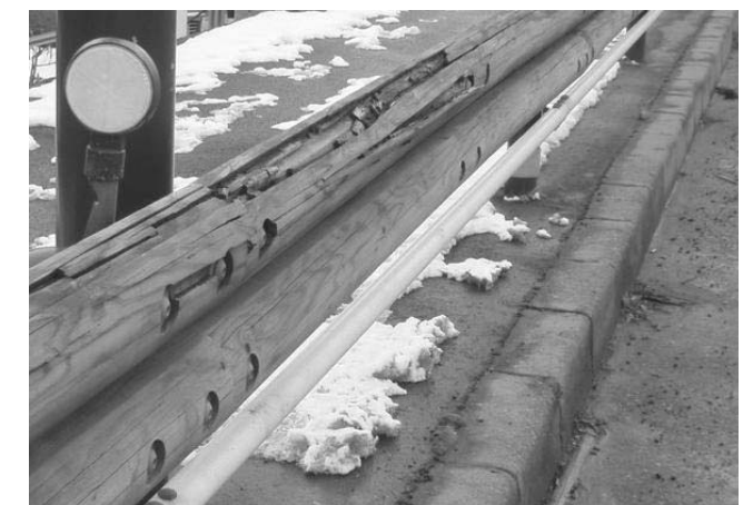
写真10 辺材部がはく離した信州型 木製 Gr 1号型 (スギ半円材+鋼板)
