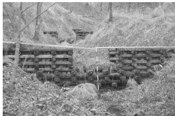
写真1 カラマツたいこ材を使用した比較的小規模の治山えん堤
