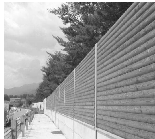
写真5 2012年に新設された木製遮音壁
