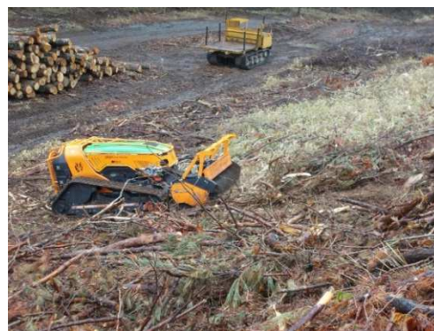
写真2 ラジコン地拵機
