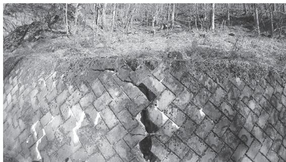
図-5 インターバルカメラにより移動撮影した擁壁の破損
