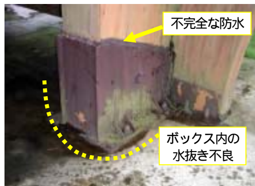
写真-3 集成材の取り付け部分の不完全な防水の例
