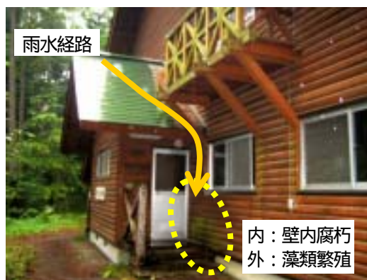
写真-2 雨仕舞いのよくない例 (雨水が壁面をつたってている)
