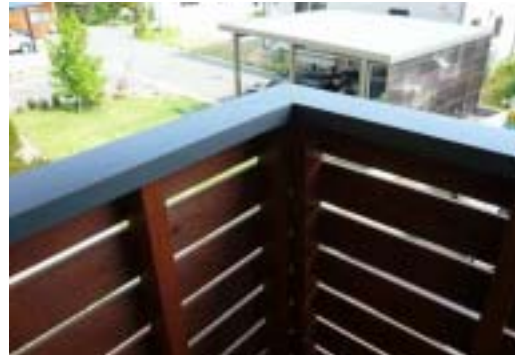
写真-5 手すり部分の被覆 （劣化しやすい天端の保護）
