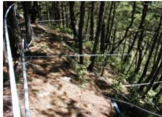
写真-5 揚水タンク・塩ビパイプを利用した広範囲な散水方式の一例(諏訪市)
