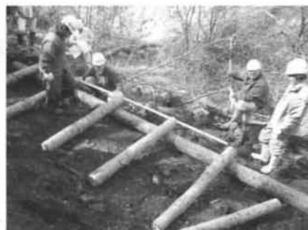
写真-1 床掘後の丸太組施工
