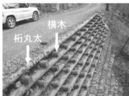
写真-2 完成後の全景
