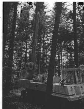
写真-1 タワーヤーダの集材状況
