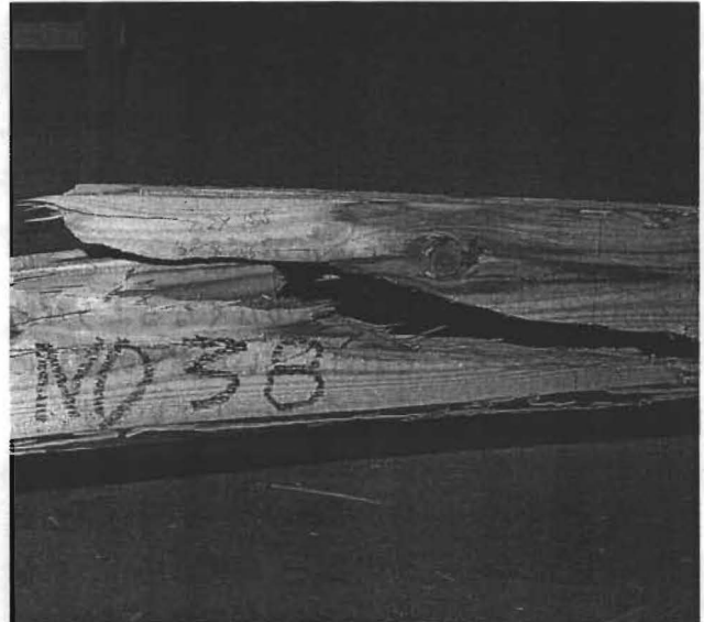
写真-2 強度試験後の被害材
