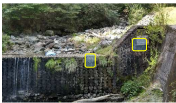
図-2 2023.9(設置後約20年)に部材交換を実施(黄色線囲み部)した岡谷市の施設(左)と、同袖部材の心材腐朽状況(右)
