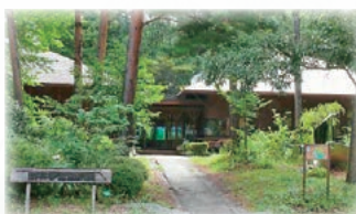
長野県林業総合センター
