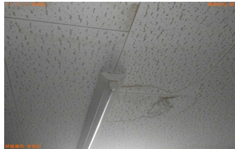
④ 2階自習室天井に漏水
