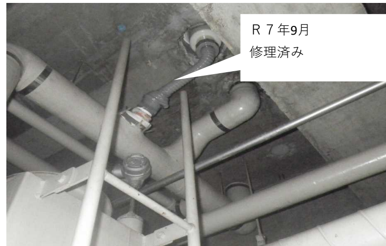
③ 1階機械室天井に漏水
