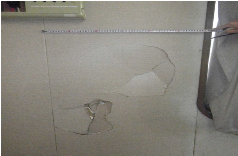
③内壁の破損状況
