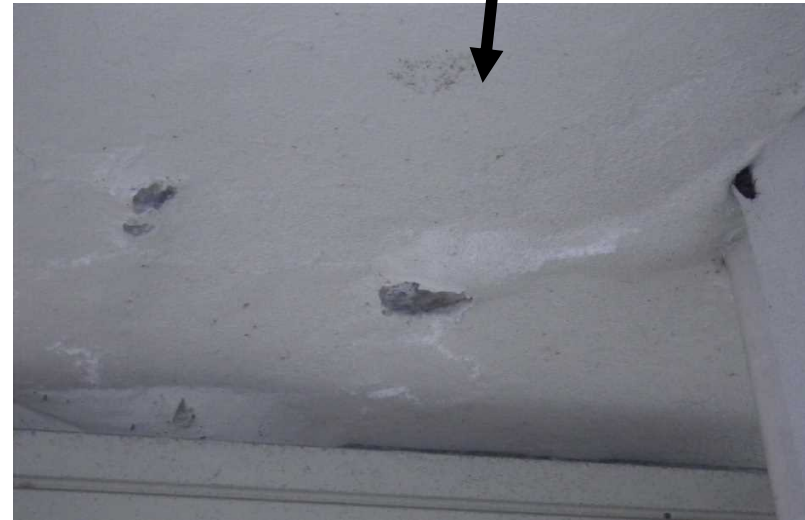
④塗装が剥がれている箇所を拡大
