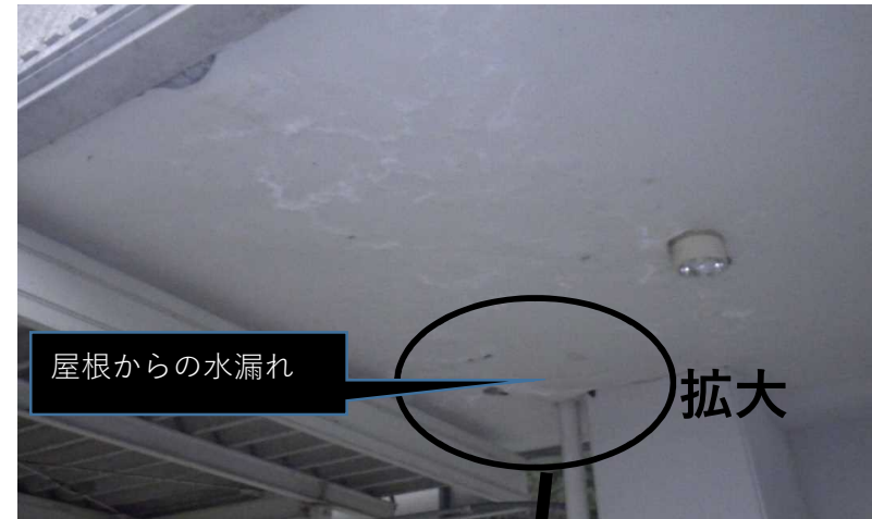
②屋根からの漏水で塗装が剥がれている状態
