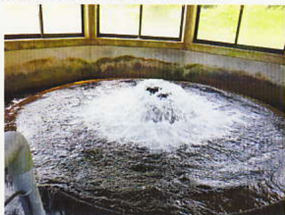
水が湧き出ている箇所（六角堂内）
