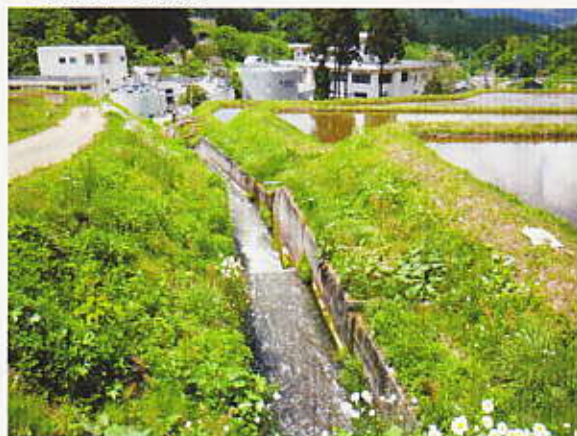
上流側から撮影
