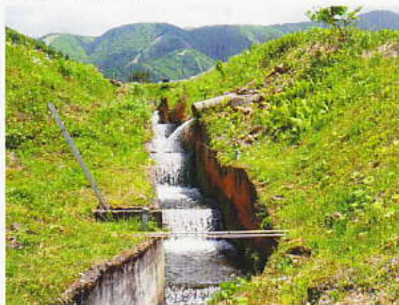
下流側から撮影
