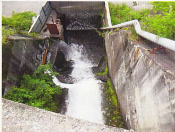
落差箇所を上から撮影
