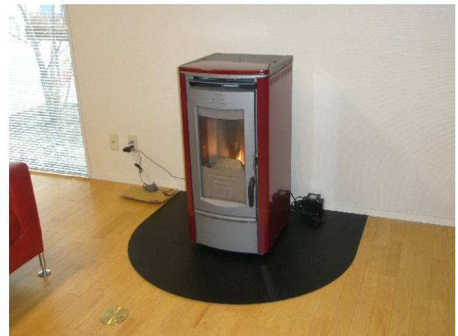
実証試験機2号 設置12月19日(月) Y宅 (長野県長野市西尾張部) 【テルモロッシET3001】
