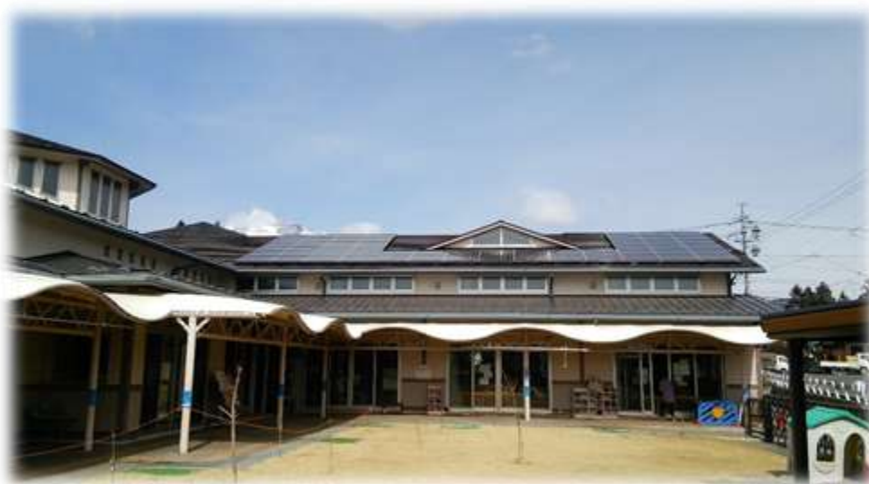
＜軽井沢中保育園に設置された太陽光発電設備＞
