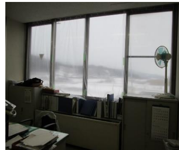
3 ビニールカーテン取付け
